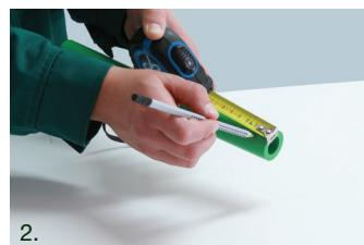
Označite dubinu zavarivanja na kraju cijevi. Cijevi i spojevi, kao i alat za zavarivanje, moraju biti čisti i suhi. Prije zavarivanja obavezno ih očistiti grubim papirnatim ubrusima bez vlakana ili čistom krpom.
