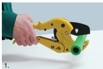
Odrežite cijev pod pravim kutom u odnosu na os cijevi pomoću škara ili okretnog noža. Krajevi cijevi moraju biti ravno odrezani.
