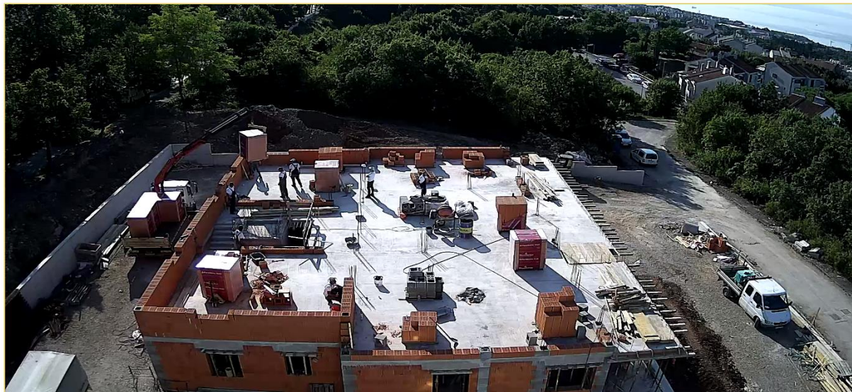
Slika 4: Snimka praćenja gradilišta na dan 23.07.2019.
